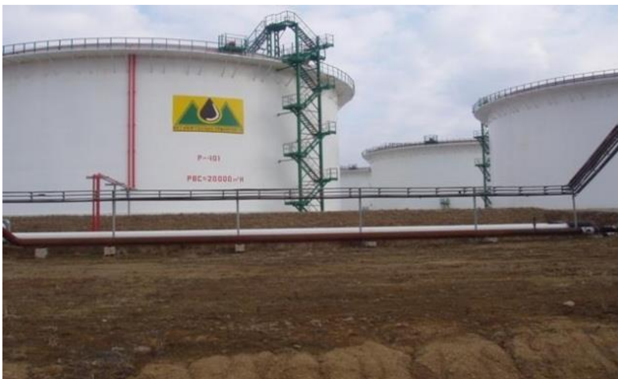
Очисні споруди ПАТ "Нафтохімік Прикарпаття"
